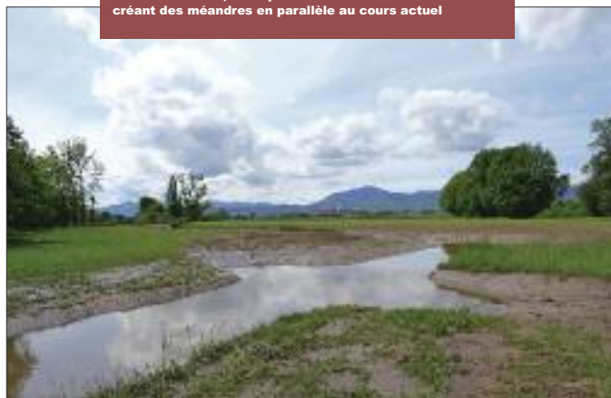
Au Bruchmuehle, exemple de renaturation sur l'Andlau en créant des méandres en parallèle au cours actuel
